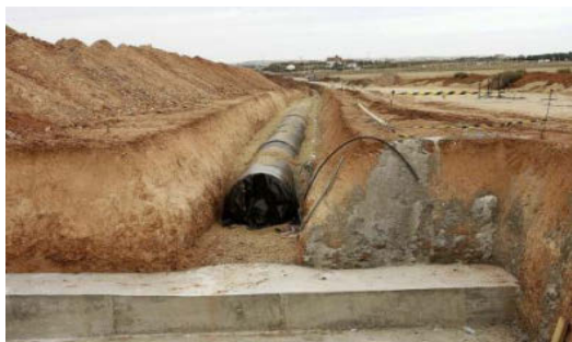
Obras de la construcción de la Tubería Manchega, en una imagen de archivo. / RUEDA
